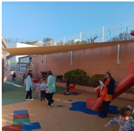
Aplicação de sombreamento em recreio exterior
